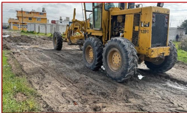
En la Colonia La Coco, se pavimentaron las Calles 10 y 8 Norte.
