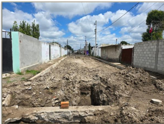
Rehabilitación de red de conducción y construcción de línea de distribución de agua potable.
