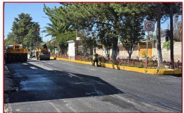
Rehabilitación de calles y bacheo en diversas zonas de la cabecera municipal.
