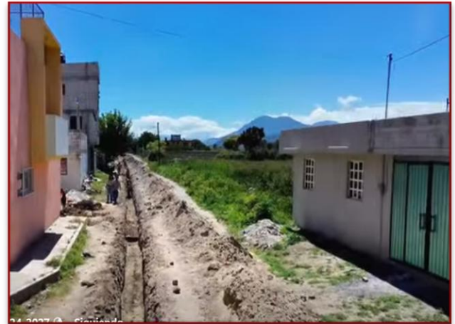
Construcción de pavimento con adoquín en la Calle 29 Oriente, entre Carretera Federal 129 y Calle 10 Sur, con un avance de más del 30%.
