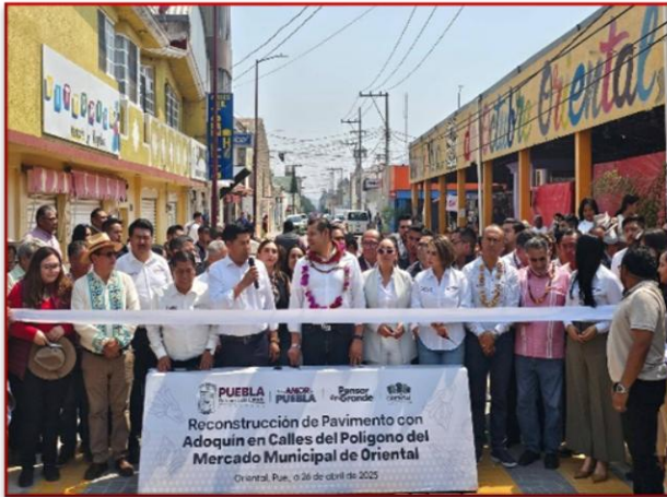
La reconstrucción de pavimento con adoquín en calles del polígono del mercado municipal de Oriental.
